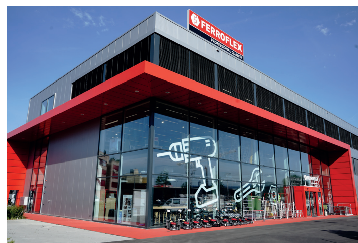
Standort Oberentfelden Einer von schweizweit elf Standorten der FERROFLEX Group
